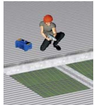
Regel 4 Dachöffnungen sichern.
