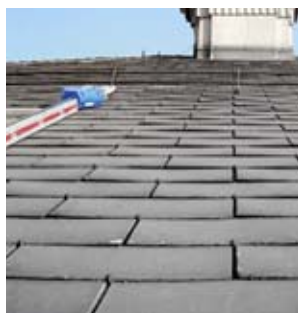
2 Dach mit asbesthaltigen Faserzementplatten
