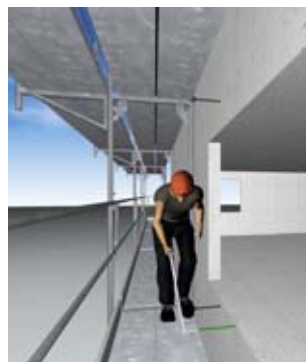
Regel 7 Gerüst kontrollieren.
