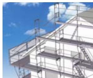
3 Steildach mit Spenglergang und Giebelschutz
