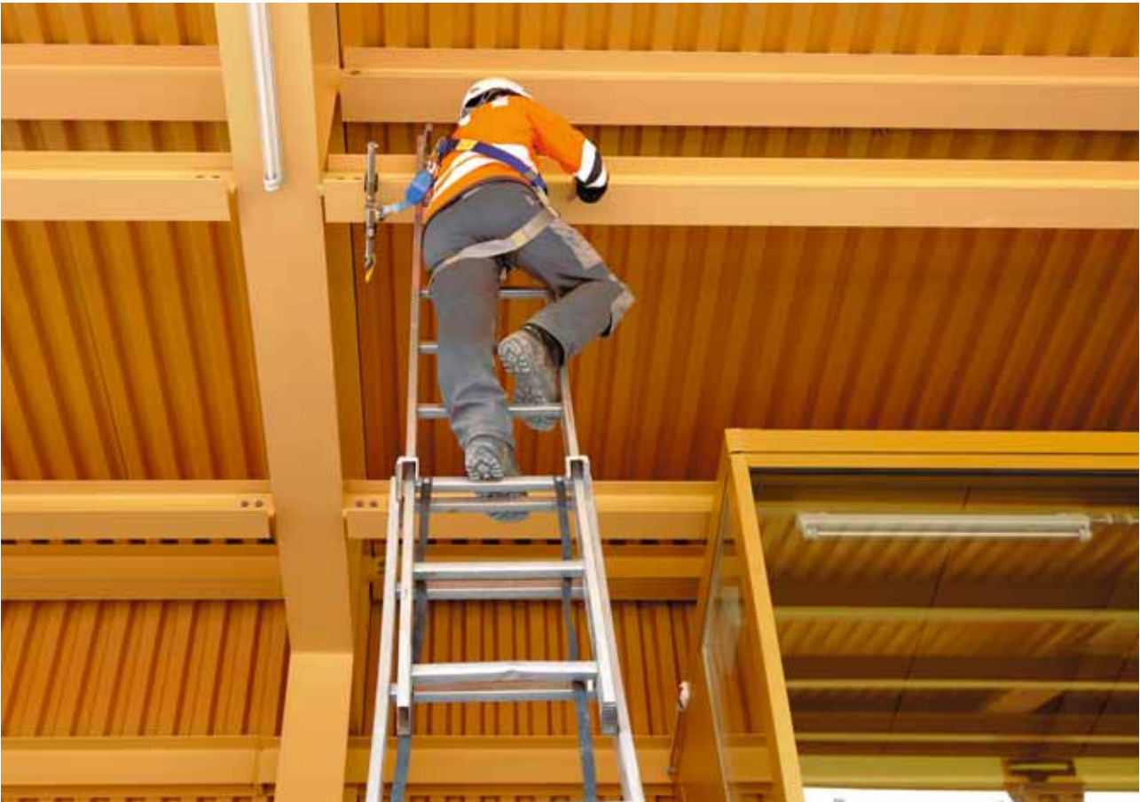
Bild 27 Gesichertes Arbeiten auf einer Leiter mit Höhensicherungsgerät und mobilem Anschlagpunkt.
