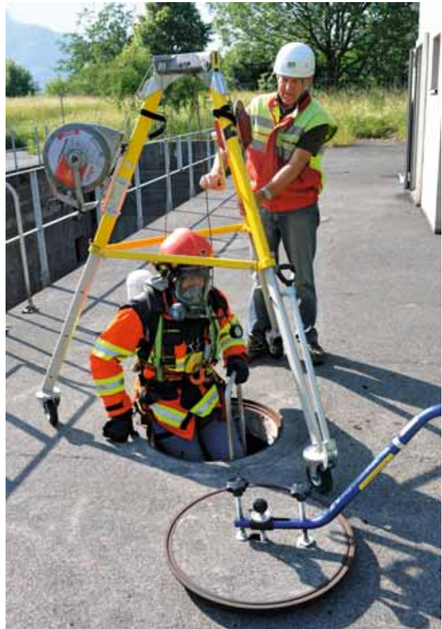
Bild 20 Einstieg in einen Schacht über eine Leiter. Sicherung durch Auffanggurt und Höhensicherungsgerät mit Rettungskurbel. Der Eingestiegene kann jederzeit von aussen mit der Rettungskurbel hochgezogen werden.
