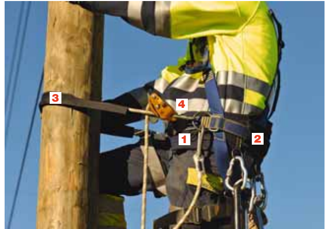
Bild 5 Gurt zum Besteigen von Masten mit Halteseil und Seilkürzer. Der Seilkürzer ermöglicht das Einstellen der Länge des Halteseils.
