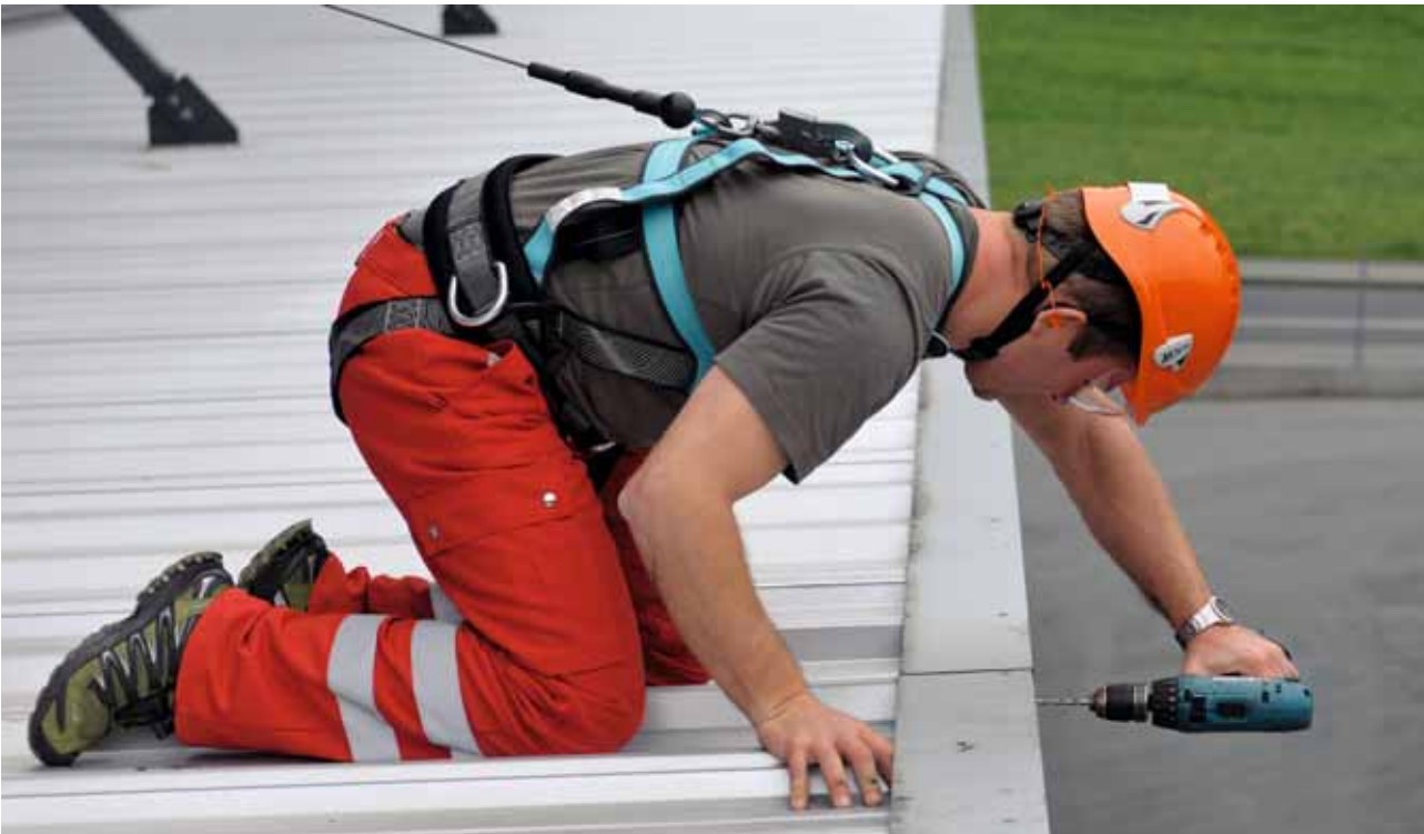
Bild 18 Arbeiten an einer Absturzkante.
