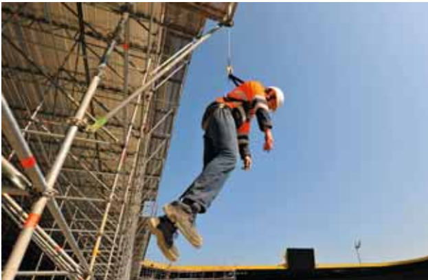
Bild 19 Eine abgestürzte Person muss innerhalb von 10 bis 20 Minuten durch eigene Mittel geborgen werden, ohne weitere Gefährdung des Verunfallten und des Retters.
