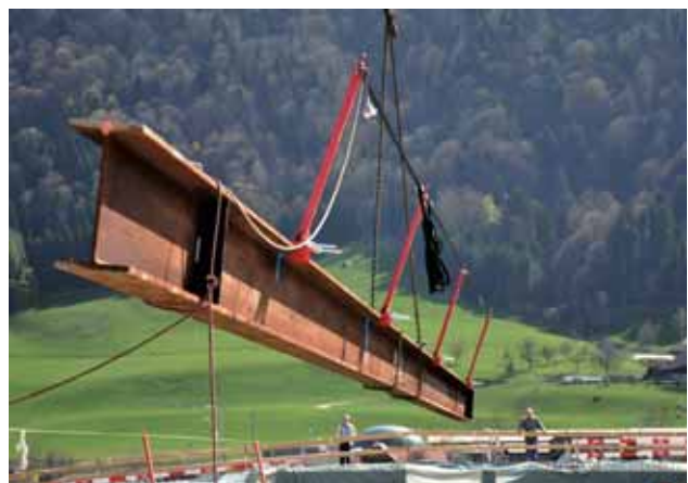
Bild 26 Gut geplant: Ein Stahlträger wird mit dem bereits vormontierten Lifeline-System auf der Baustelle eingehoben.
