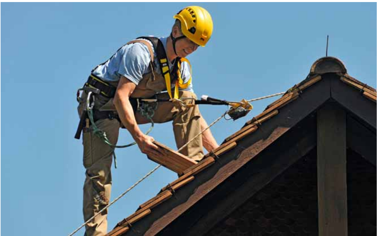
Bild 9 Reparaturarbeiten auf einem Dach, Sicherung mit Auffanggurt und Sicherungsseil.
