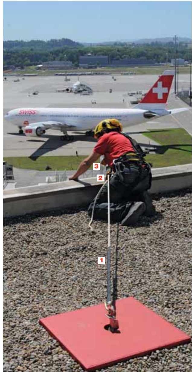
Bild 13 Auf einem Dach arbeitende Personen, die durch Auffanggurten an einem Sicherungsseil gesichert sind.
