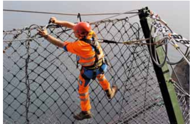
Bild 8 Sicherung mit Auffanggurt und Halteseil.
