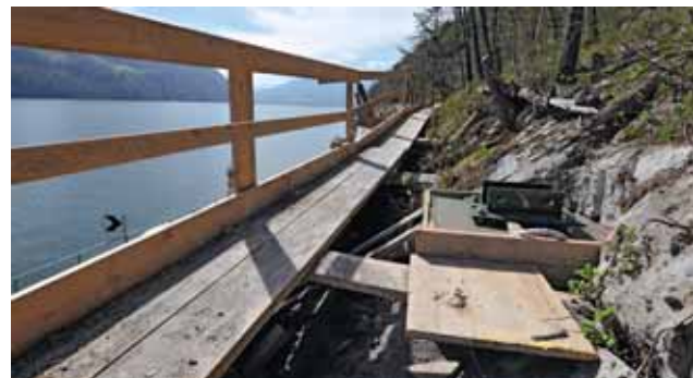
Bild 30 Bei umfangreichen Arbeiten im Gelände (z.B. Felssicherung) müssen die Zugänge zu den Arbeitsplätzen sicher gestaltet werden. Der Seitenschutz ist den Gegebenheiten angepasst zu erstellen (z.B. vollflächiges Netz oder Handlauf gemäss Art. 15 Abs. 2 BauAV oder dreiteiliger Seitenschutz gemäss Art. 16 BauAV).
