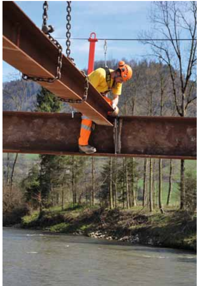
Bild 25 Montage einer Stahlkonstruktion mit Sicherung an einer horizontalen Lifeline.
