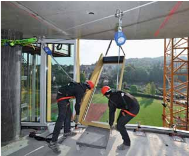
Bild 24 Arbeiten an einer Absturzkante.
