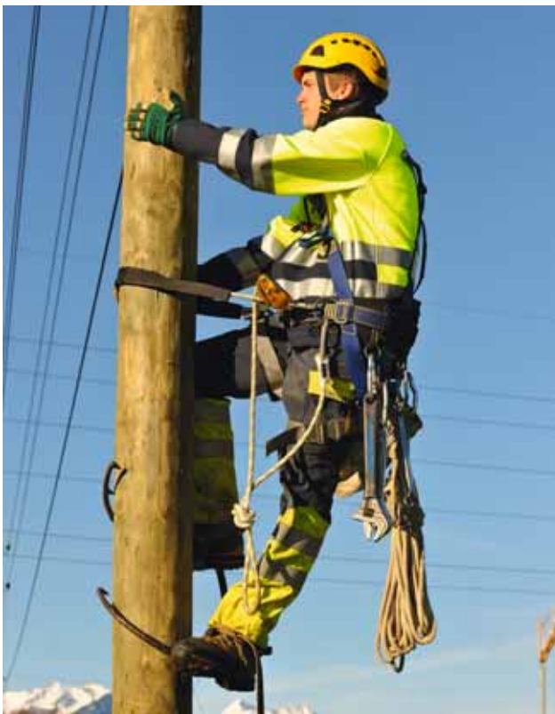
Bild 6 Freileitungsmonteur besteigt mit Steigeisen und Masthaltegurt einen Holzmast. Hier ist kein zusätzliches Sturzauffangsystem notwendig.
