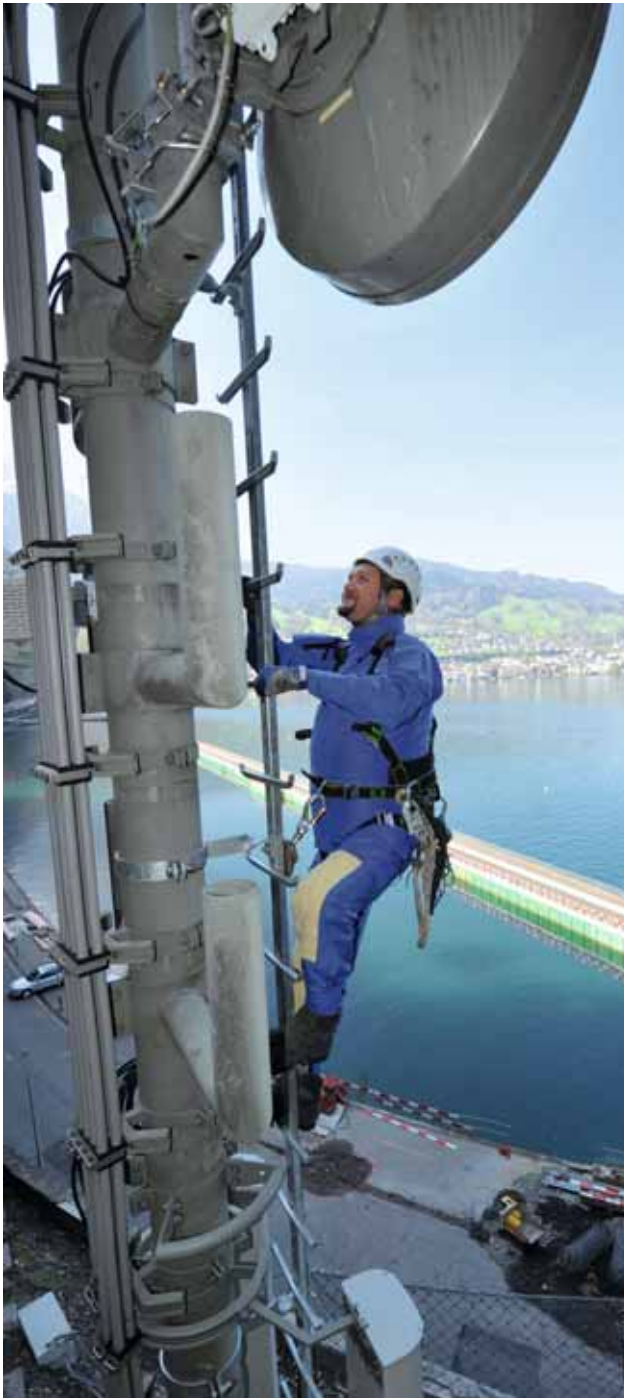
Bild 14 Mit einem Steigschutz an der Mittelschiene einer ortsfesten Leiter gesicherter Monteur.
