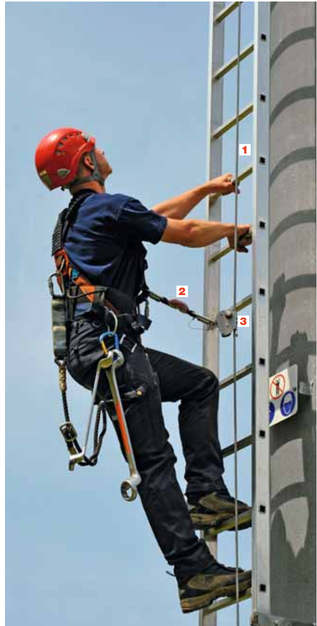
Bild 16 Durch Auffanggurt an mitlaufendem Auffanggerät gesicherte Person.
