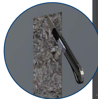
Abb.: Dämmung einsetzen und einschlitzen mit z.B. einem Cuttermesser:
